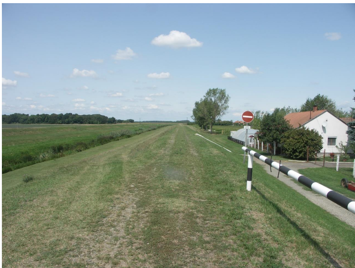
1. ábra A jelenlegi földút az árvízvédelmi töltésen, a 3126-os út környezetében
